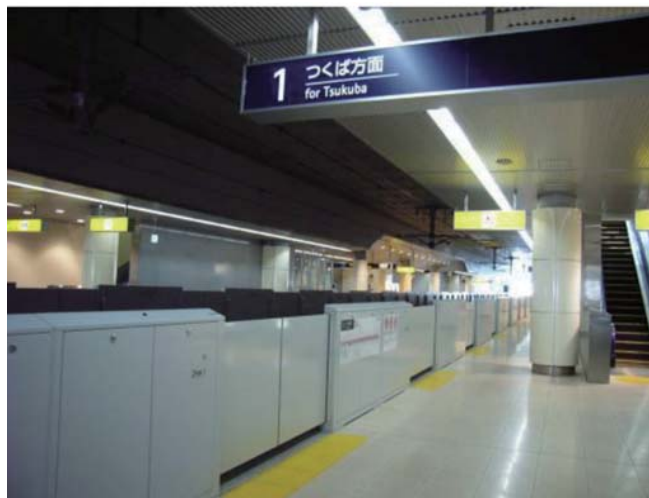
ホームドアの設置
