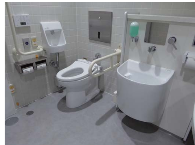
オストメイト設備のついただれでもトイレの設置
