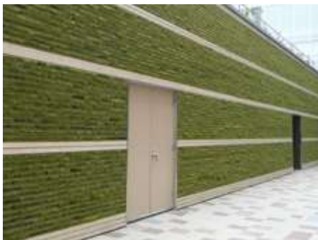
しっかりと管理された壁面緑化
