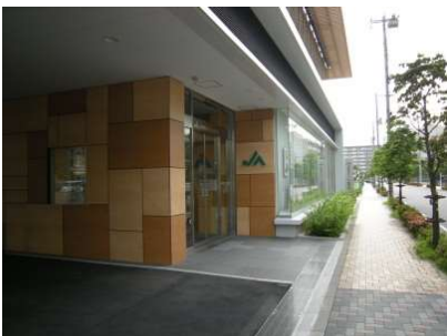
敷地外と協調性を持たせた植栽 外壁部分にも木調を取り入れること により温かみが増している
