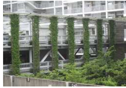
機械式駐車場の緑化
