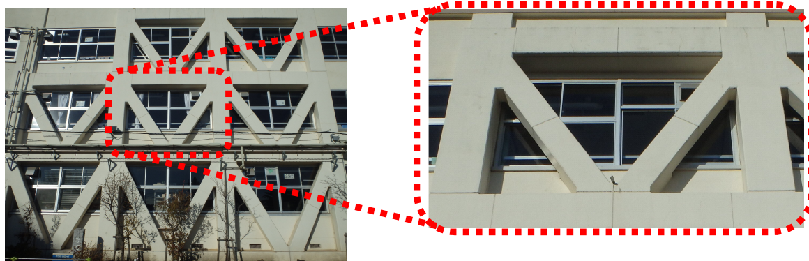
緊急輸送道路沿道建築物と同規模の建築物における耐震改修事例
