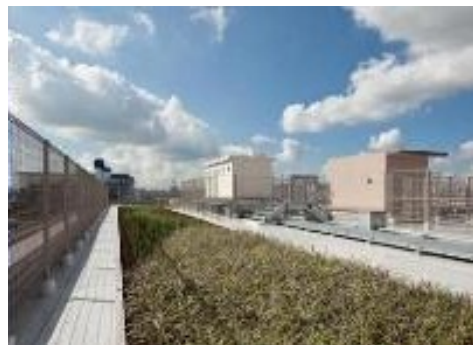
屋上緑化（西新井小学校）
