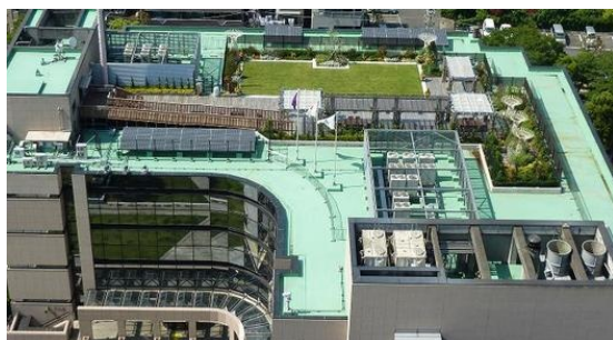
区役所北館屋上 (エコガーデン・太陽光発電設備)
