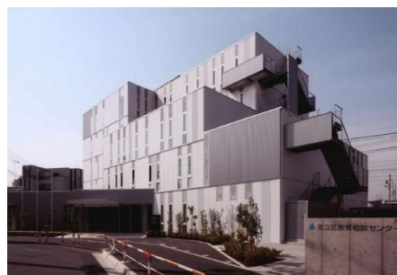
教育相談センター (屋上や外壁に厚い断熱材や窓ガラスに複層ガラスなどを採用)
