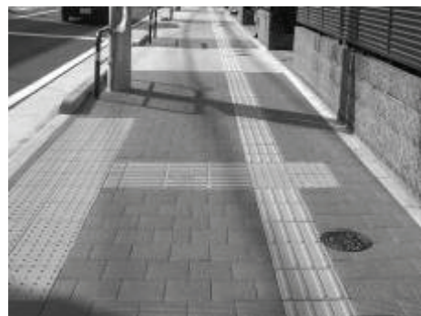
誘導ブロックを整備し、車道との段差を極力なくした歩道のセミフラット化
