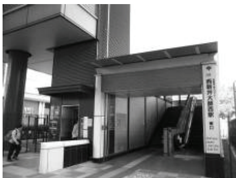
だれもが利用しやすいように、階段、エスカレーター、エレベーターが併設された駅舎
