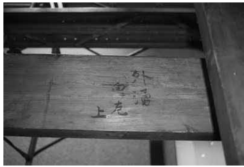
【写真1】「外湧 向テ 左上」と墨書。 組み上げの際に、部材の使用位置を示したものの。
