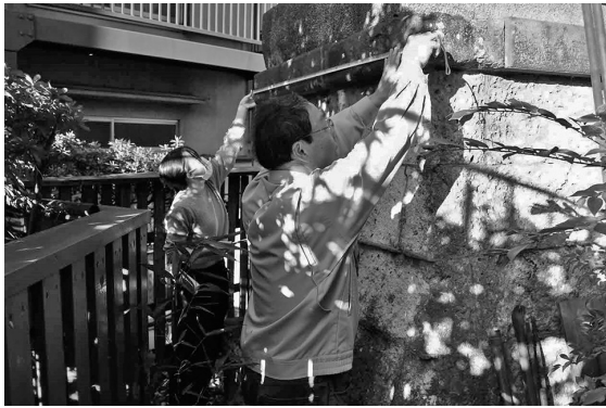
難しく狭い場所での計測作業
