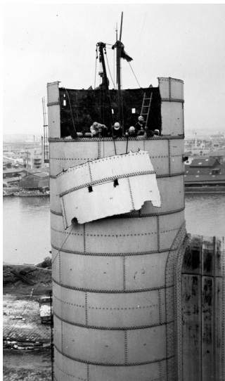
煙突の解体作業
