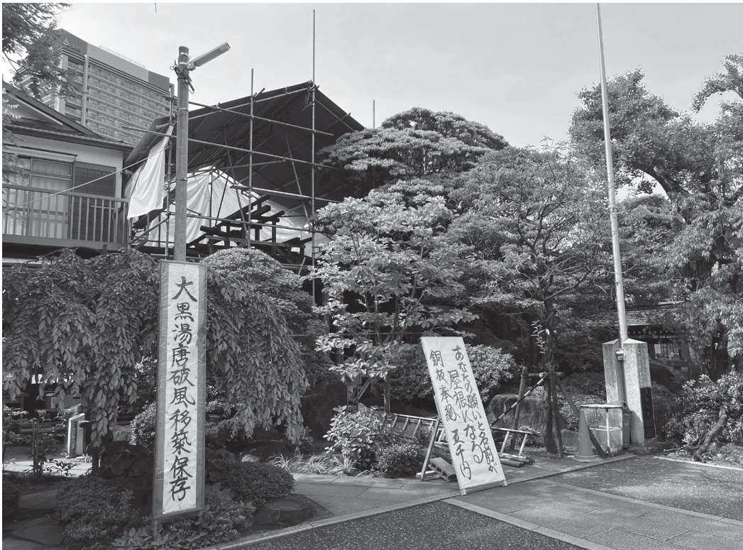
大黒湯の唐破風移築の工事がすすむ安養院（足立区千住五丁目） 3月初めから工事が始まり、銭湯遺産の一つが受け継がれようとしている。
