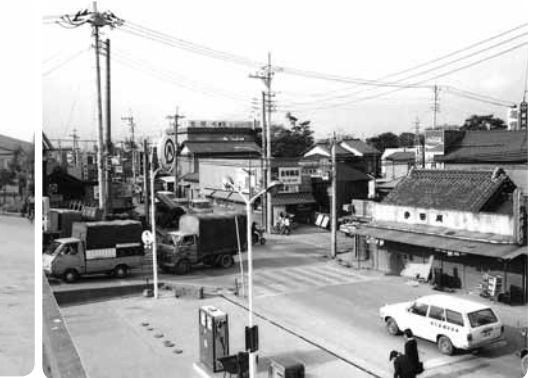
内匠橋東交差点付近 南花畑三丁目交差点より西方面を見る
