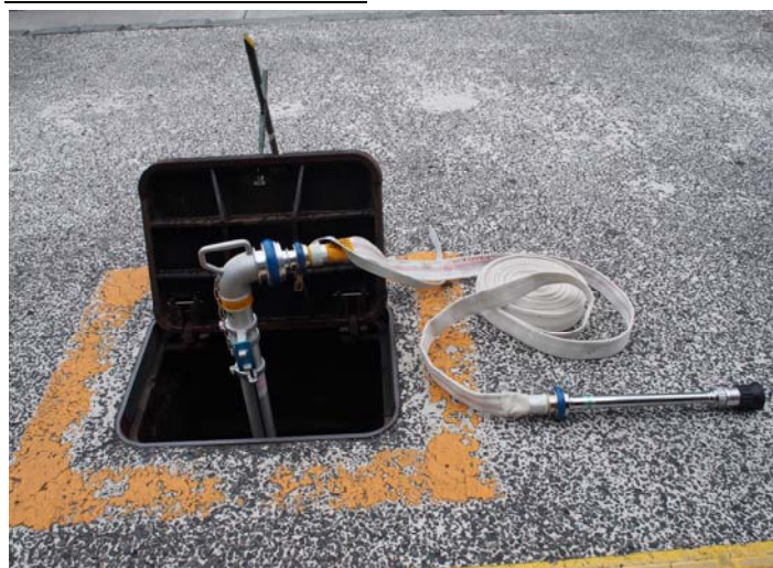
画像1 スタンドパイプ
