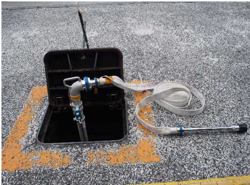
画像1 スタンドパイプ
