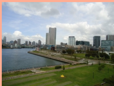
豊洲地区 豊洲を含めた臨海部は、マンションやオフィスビル等の開発が進んでいます。2020年の東京オリンピックでは、周辺の施設が会場として活用される予定です。
