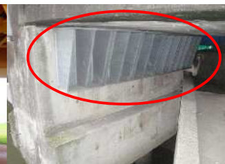
落橋防止対策例
