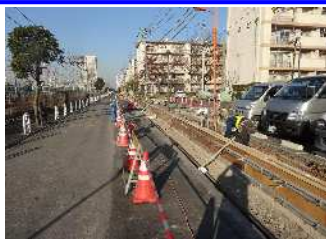
側道付替工事
