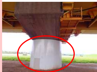
橋脚の補強例
