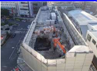
東口駅ビル解体
