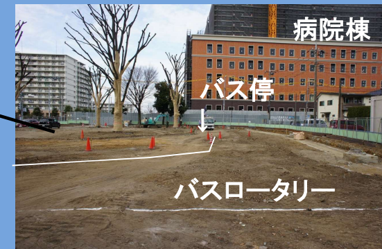
バス転回場工事状況
