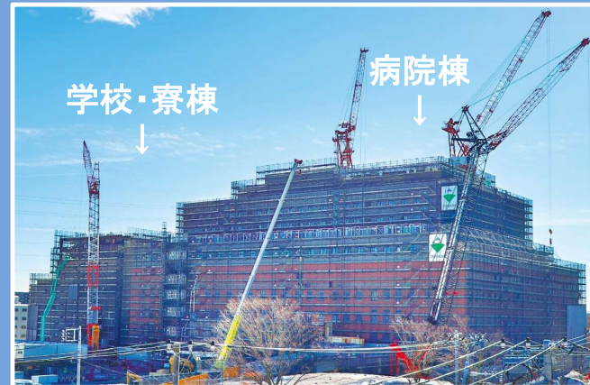
東京女子医科大学附属足立医療センター工事状況
