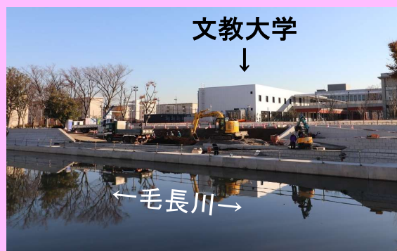
親水拠点工事状況
