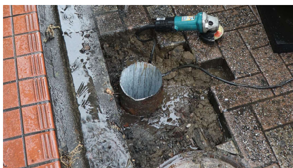
※街路灯ポール撤去後の状況 （最終的に地面を補修）
