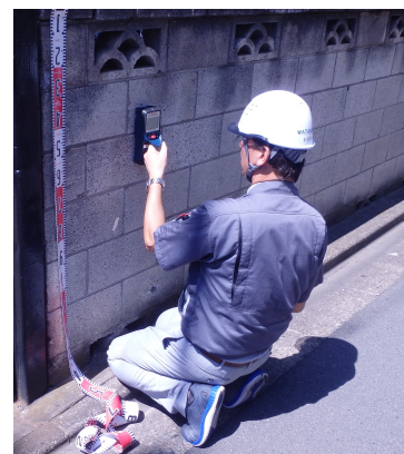
鉄筋探査の様子
