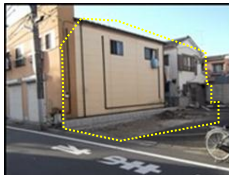
老朽建築物解体後
