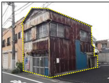
(事例) 老朽建築物解体前
