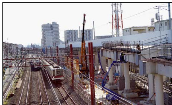
高架橋工事(H29. 1. 18撮影)
