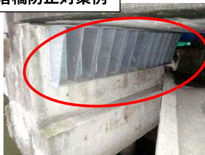
落橋防止対策例
