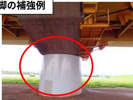
橋脚の補強例
