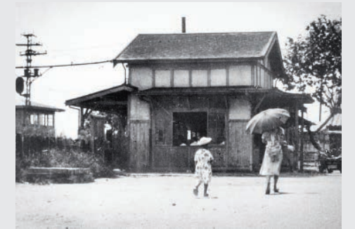
昭和26年当時の竹ノ塚駅駅舎。ホームは待合室以外には屋根が無い簡素な造りだった
