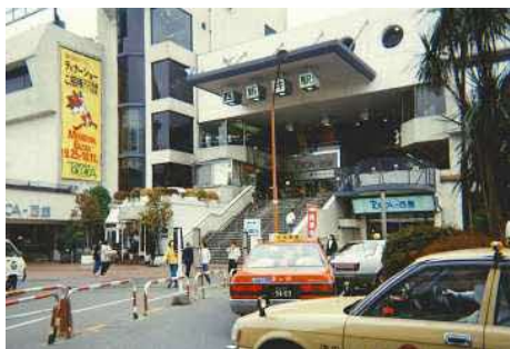
西新井駅西口の出入口階段
