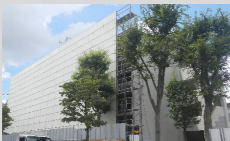
解体中の新田三丁目区営住宅
