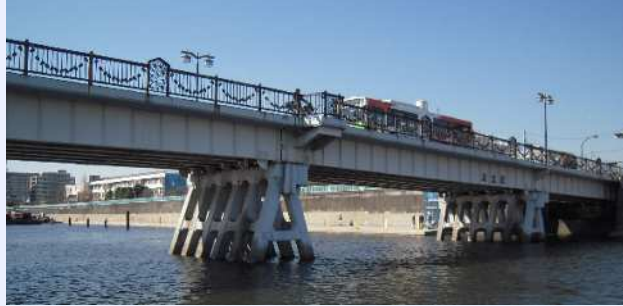
現状の新田橋
