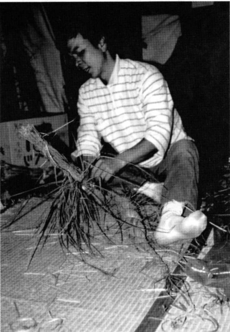
作るときは、足踏み式縄ない機やヨシズ機を用いて、中川の葦やリンボウ、ダイコジメなどの材料を用いてつくります。佐野では、昭和の初めころに新しい産地として発展し、大谷田や北三谷でも依頼によって作られるようになりました。
