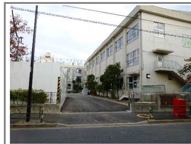
新設した「南門」
