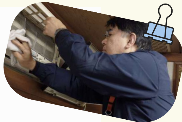
写真（ちょっとサポートにてエアコン掃除をする委員）
