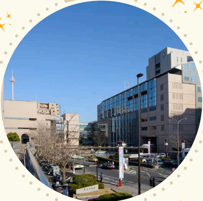
写真（足立区役所）
