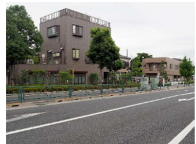
無電柱化された道路(舎人公園通り)
