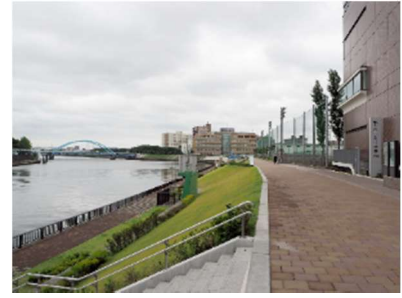
隅田川沿いに整備された緩傾斜型堤防 (千住桜木一丁目)
