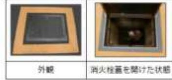
水道本管に直結する方法で、消防車両に消防用水を供給する施設。
