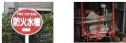
防火のために地下等に貯水してある水槽(写真左)で、ポンプで吸い上げて消火に利用する。地震時、消火栓の配管が壊れ、使えなくなった際にも有効。
