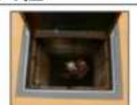
消火栓蓋を開けた状態
