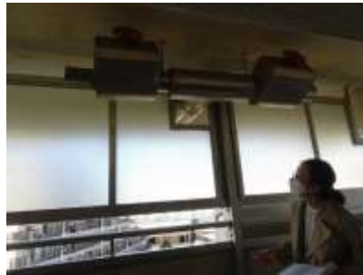
6 階に設置されている上層階への送水用配管
