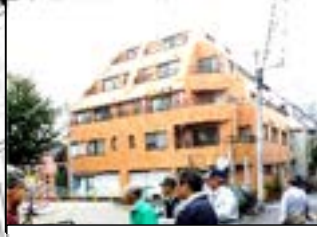
5階建てマンション
