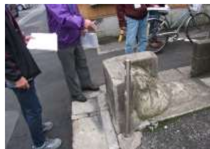
曲がり角がコンクリートでかためられてしまって車（緊急車両）が曲がれない
