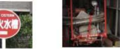
地下等に貯水してある水槽(写真左)で、ポンプで消火に利用する。地震時、消火栓の配管が壊れ、使
