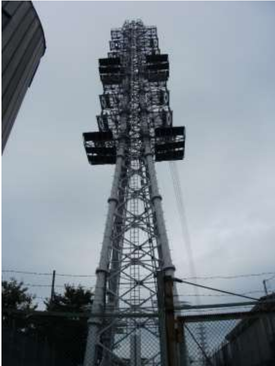
↑ 巨大な高圧線の鉄塔 浸水時の安全性について確認が必要
