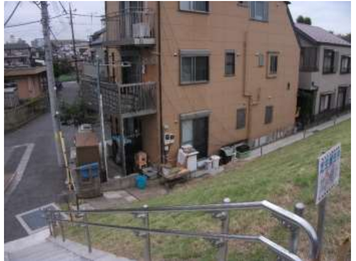
↑ 中川の堤体から見た家々 堤体は2階の高さを超えている
