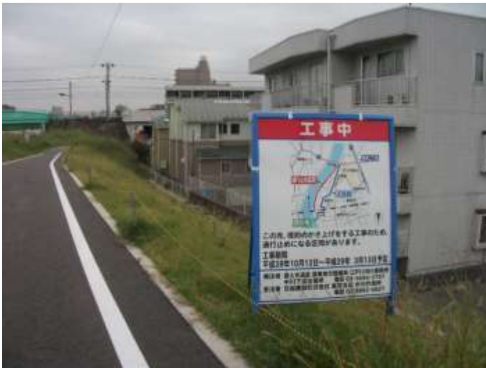
↑ 工事中の表示 現在も堤防のかさ上げ工事が進められている
