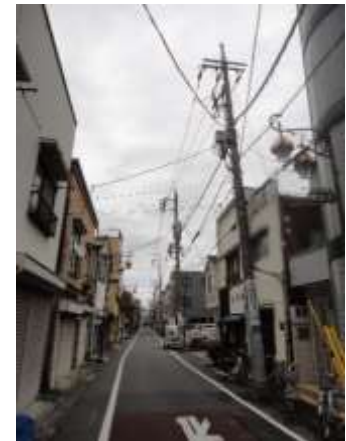
電柱が傾いている。地震時に倒れないか
