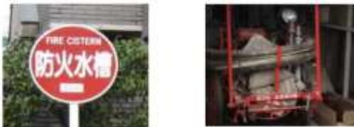
防火のために地下等に貯水してある水槽(写真左)で、ポンプで吸い上げて消火に利用する。地震時、消火栓の配管が壊れ、使えなくなった際にも有効。
