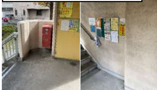
5号棟 1階東階段前（消火器・掲示板）
