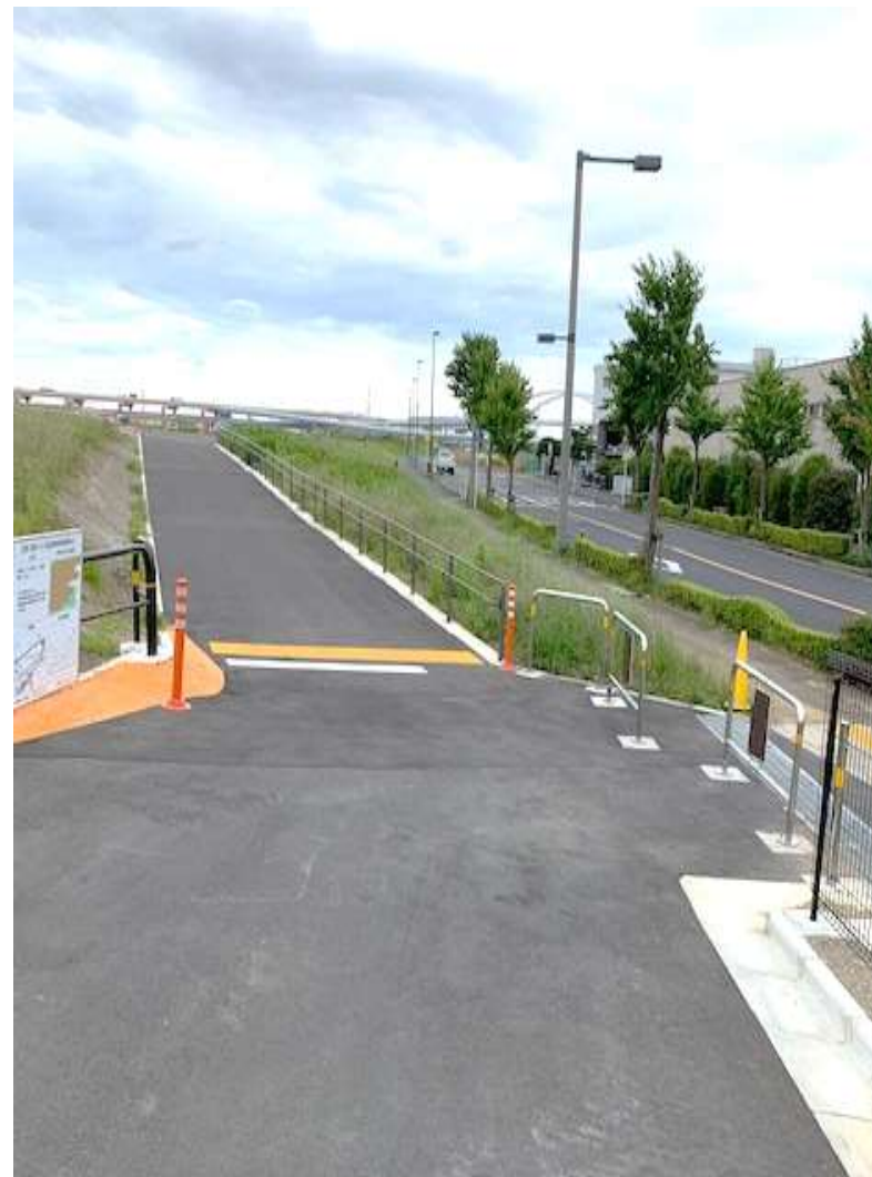
①足立区整備の斜路
