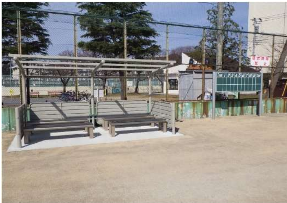
パーゴラ、ベンチ、スコアボード完成写真
