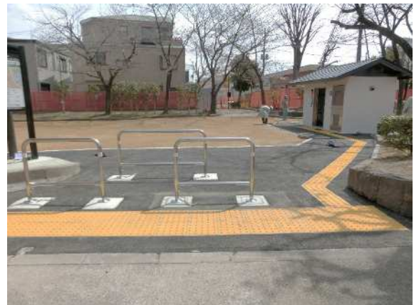
出入口の改修、点字の設置
