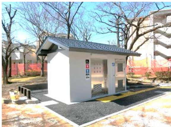
新しいトイレの設置
