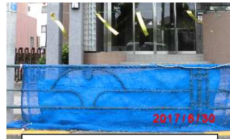
ブルーシート及び防鳥テープを設置
