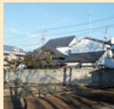
▲老朽危険家屋取り壊し後
