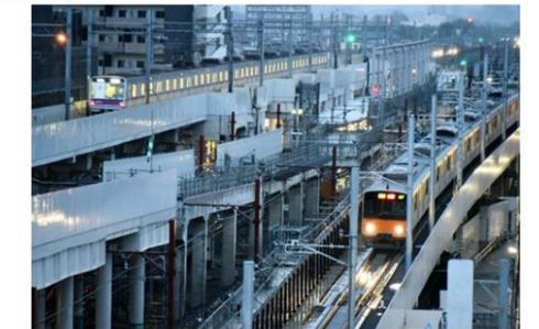
令和2年9月に上り急行線が高架化となり、これにより踏切横断距離が縮小された。引き続き、上下緩行線の高架橋を構築していく。また、工事の進捗に応じて周知看板やHP、広報等を活用して情報発信を行っていく。
