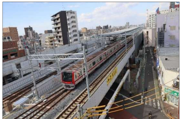
事業完了後の赤山街道付近
