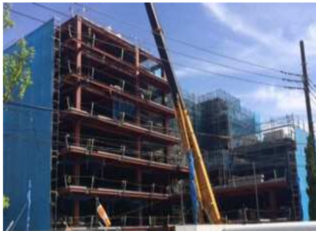
特別養護老人ホーム(仮称)レスパート千住建設の様子
