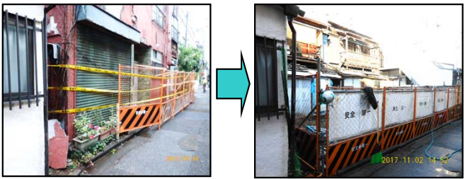
解体前 解体後
