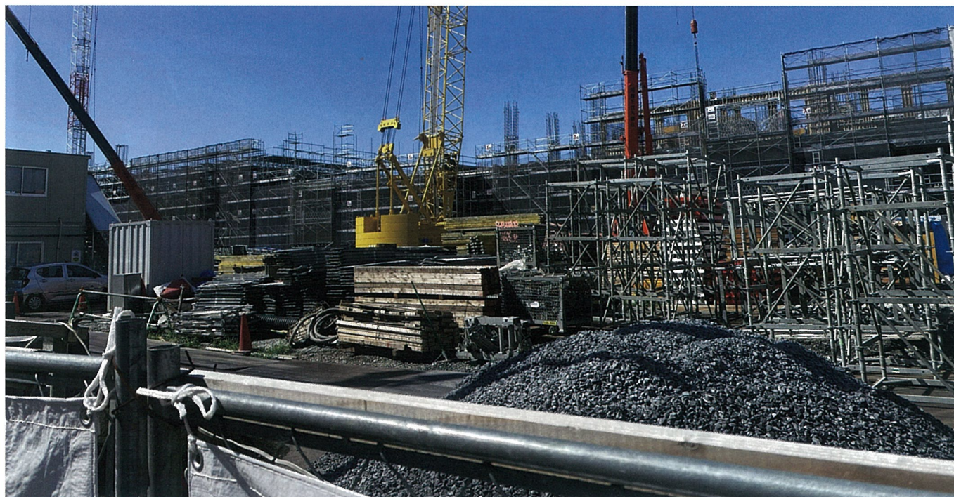
▲鹿浜未来小学校建設中
