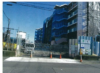
上沼田第三アパート自治会・団地建て替えの様子
