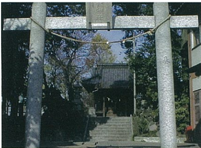
鹿浜押部町会・建て替えを待つ八幡神社（令和4年中建て替え予定）
